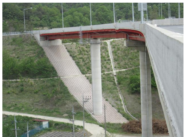
8공구 화산JCT R-H교
