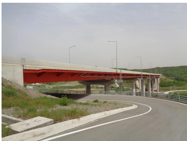
8공구 화산JCT R-A1교
