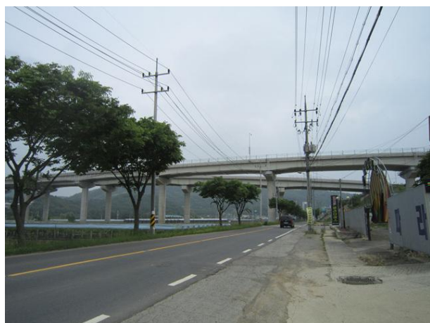
10공구 영천JCT R-A교
