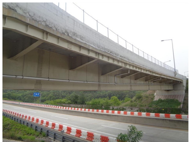
8공구 화산JCT R-A교
